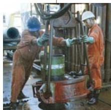
Instalação do poço
