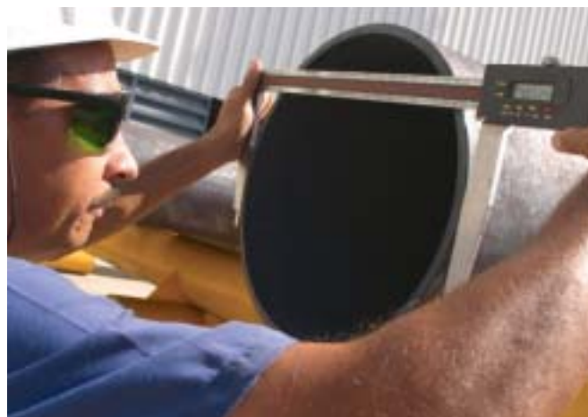
Fase final do Tratamento Térmico: conferência de diâmetro do tubo após revenimento.
