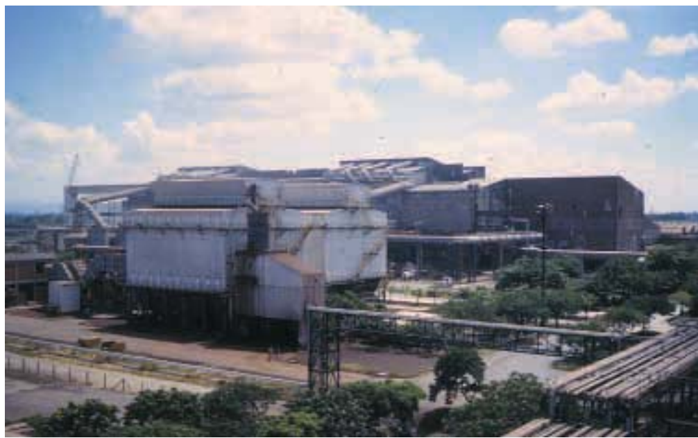
▼ Aciaria elétrica – Sistema de captação de pó primário e secundário combinado com 2.200.000 m 3 /h de capacidade.
