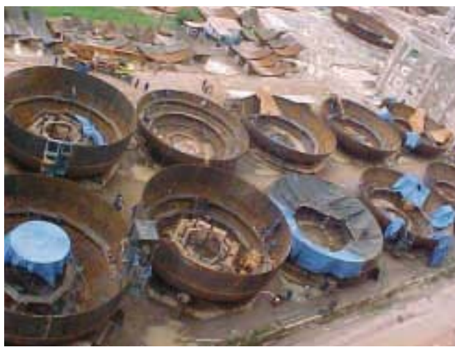
▼ Sistema de silos e digestores de alumina durante a montagem.
