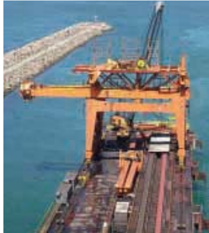
▲ Máquina descarregadora de carvão durante a montagem.
