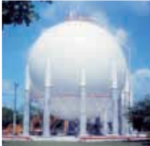
▲ Esfera com 12 metros de diâmetro para estocagem de oxigênio.
