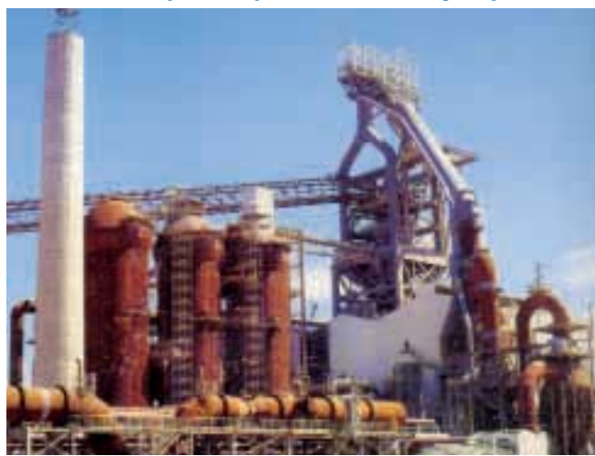
▼ Alto-forno com capacidade de produção de 5.500 t/dia de gusa líquida.
