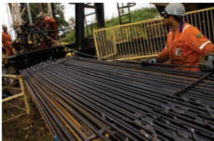
Running de hastes no poço da Petrobras em Aracajú (SE).
